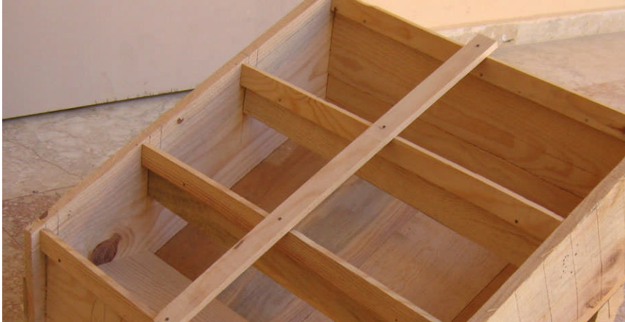
Resim 2.8a: Tek kollu dz merdivende yan tahta uygulaması
