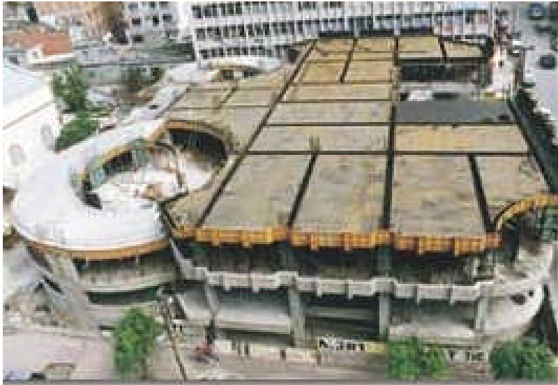
Resim 1.5b: Kirişli hazır betonarme döşeme kalıbı uygulaması
