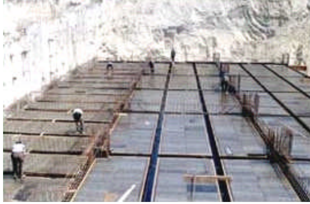
Resim 1.5a: Kirişli betonarme kalıbı uygulaması
