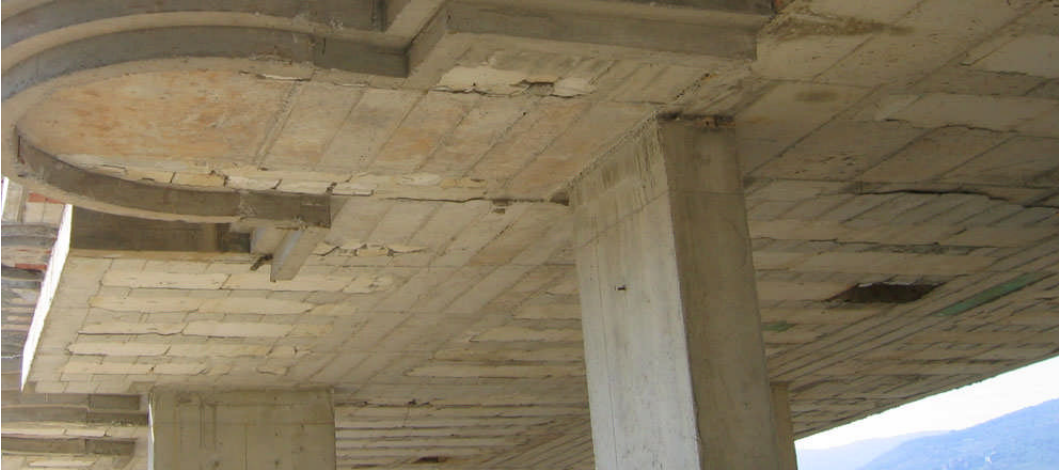
Resim 1.2: Bloklularak yapılmış nervürlü betonarme döşeme
