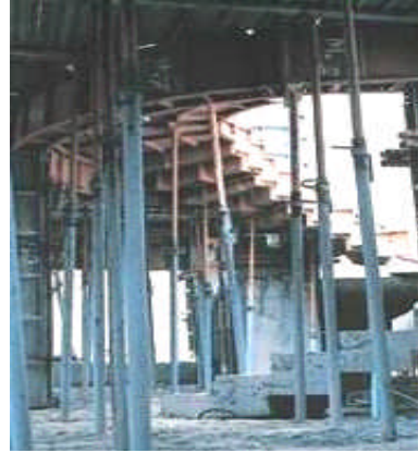
Resim 2.2b: Tam döne1 merdiven kalıbı
