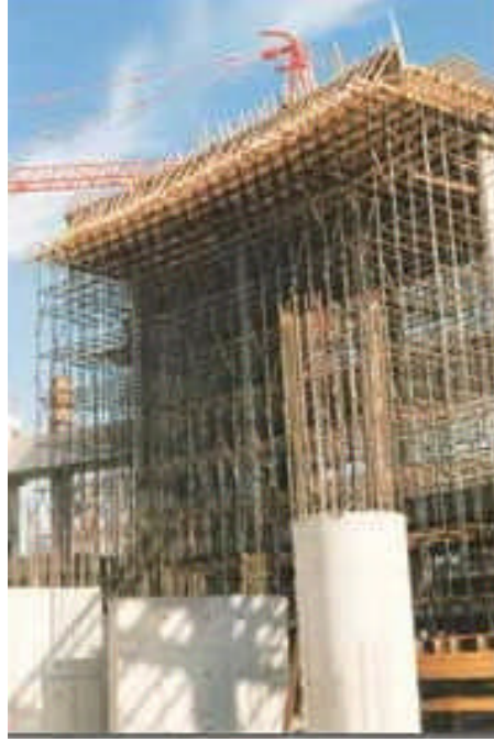
Resim 1.8b: Betonarme döşeme kalıplarında taşıyıcı kiriş uygulaması
