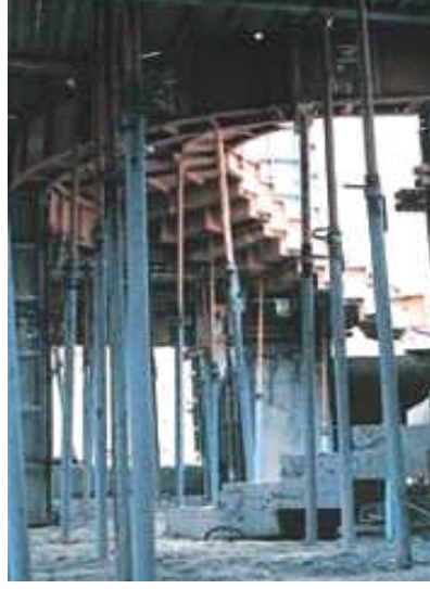
Resim 2.7b: Hazır metal kalıp ile dnel merdiven kalıbı uygulaması
