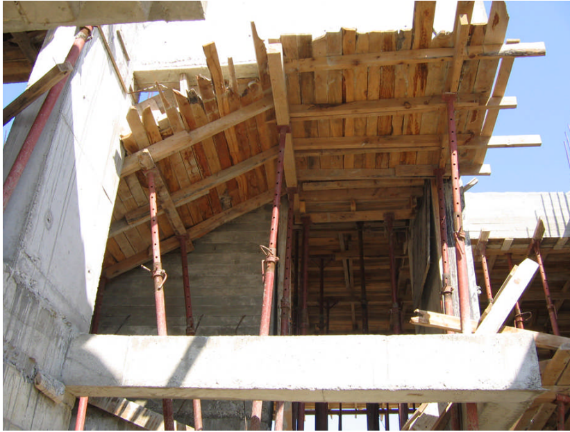
Resim 2.7a: Merdiven kalıbı döşeme tahtası uygulaması
