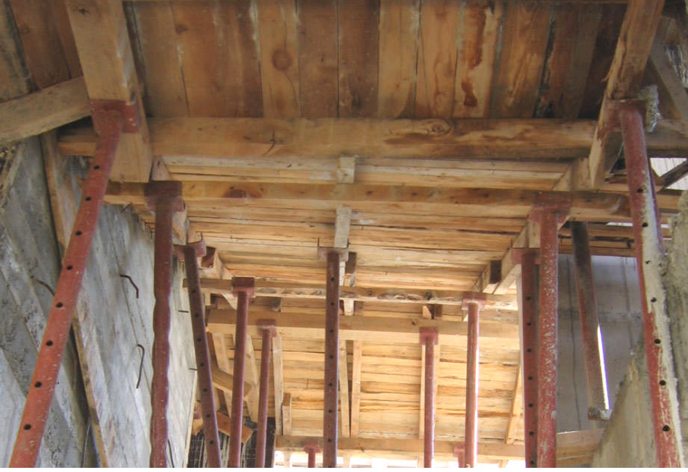
Resim 2.4: Merdiven kalıbı boyunduruklarının dikmeler üzerine yerleştirilmesi
