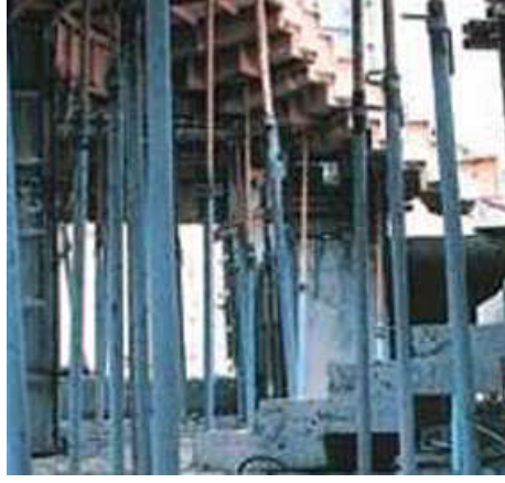
Resim 2.11b: Betonarme merdiven hazır kalıp uygulamasında dikmeler
