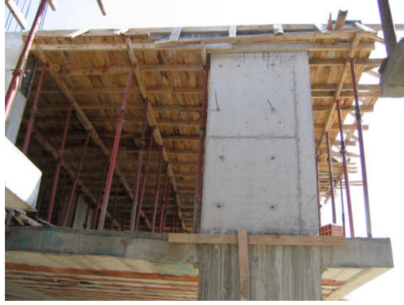
Resim 1.10: Betonarme döşeme kalıp tahtalarının yerleştirilmesi
