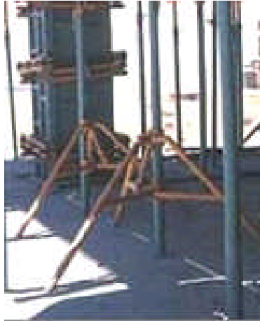
Resim 1.8a: Metal taşıyıcı dikmelerin yerleştirilmesi
