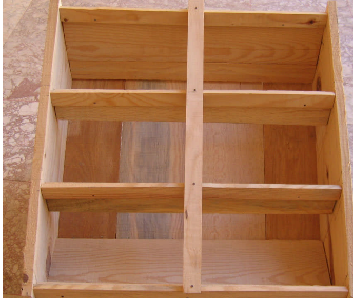
Resim 2.8b: Betonarme merdiven kalıbı yan tahta uygulaması
