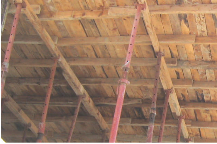
Resim 1.7: Betonarme kalıp taşıyıcı kirişlerin yerleştirilmesi
