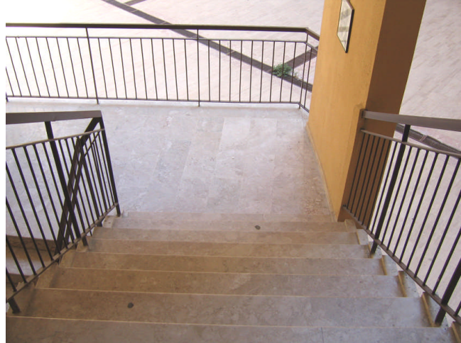
Resim 2.1: Çift kollu sahanlıklı betonarme merdiven
