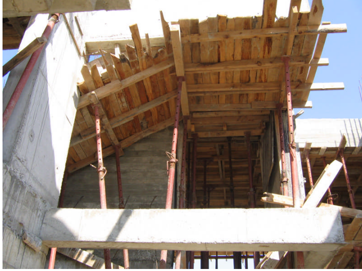
Resim 2.3: Kat yüksekliği ile beraber yapılmış merdiven kalıbı
