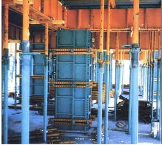
Resim 1.6: Örnek metal kalıp ve dikme uygulaması
