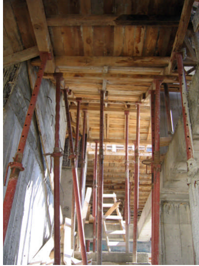
Resim 2.11a: Betonarme merdiven kalıp dikmeleri
