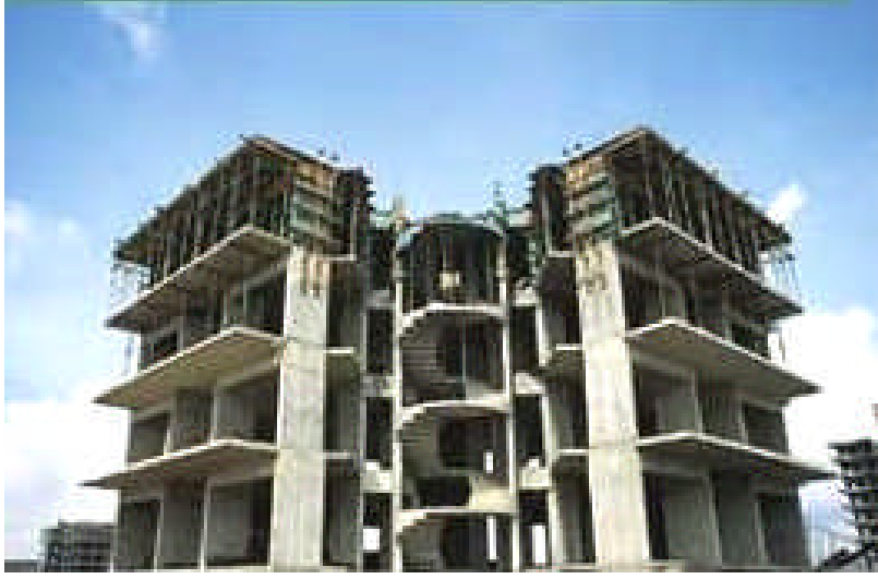
Resim 1.3a: Betonarmesi dökülmüş merdiven ve döşeme kalıbı
