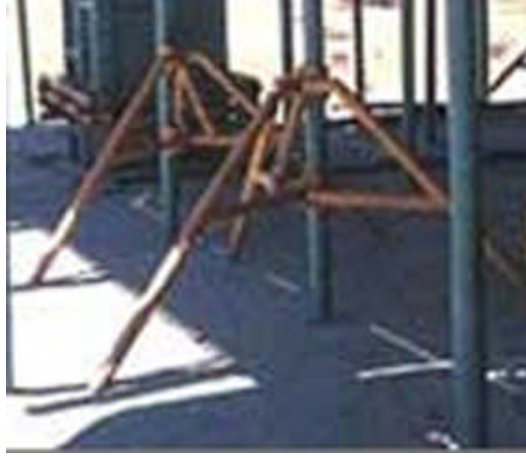
Resim 1.12: Metal taşıyıcı kirişlerde kirişlere destek uygulaması
