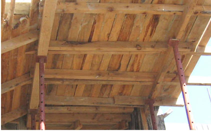
Resim 2.6: Merdiven kalıbı ızgara uygulaması
