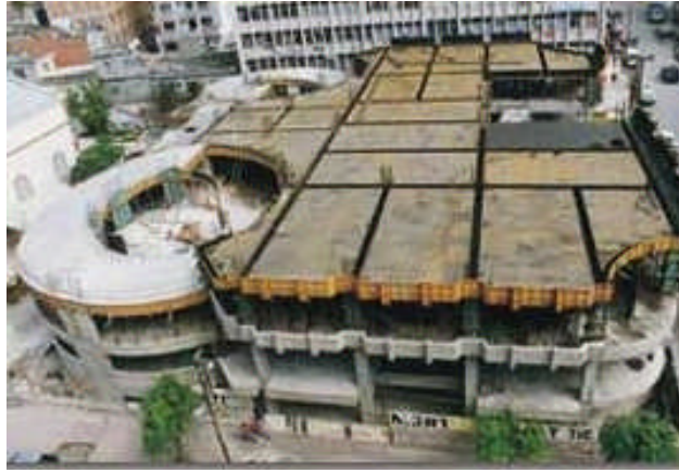
Resim 1.10a: Betonarme döşeme yüzey uygulaması
