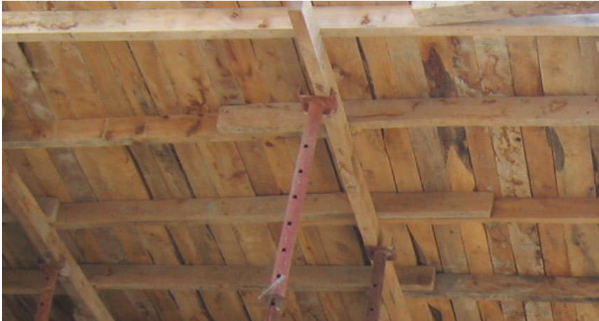
Resim 1.9: Taşıyıcı kirişler üzerine ızgara kayıtlarının yerleştirilmesi
