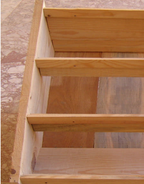
Resim 2.9: Alın tahtalarının yerleştirilmesi
