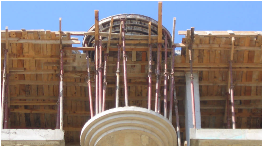
Resim 1.3b: Betonarme düz döşeme kalıbı
