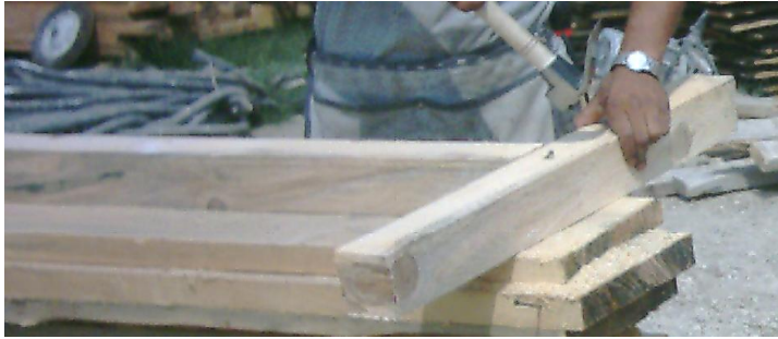
Resim 1.55: Başlığın dikmeye çakılması
