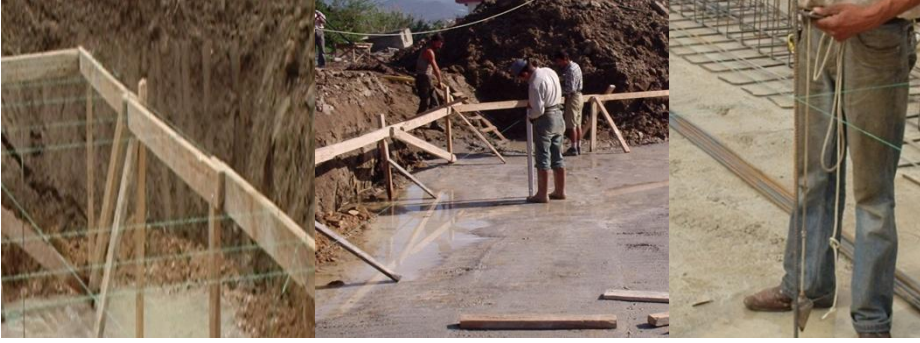
Resim 1.45: İp iskelesinin kurulması ve tesviye betonu
