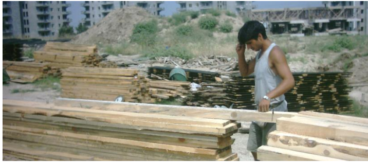
Resim 1.52: Dikme boyunun ve başlığın ölçülmesi
