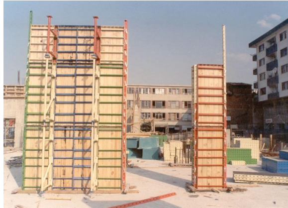
Resim 1.40: Plywood panel kalıp uygulamaları
