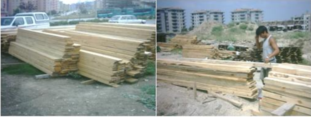
Resim 1.32: Ahşap kalıplık kereste malzemeleri
