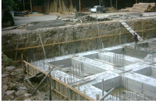
Resim 1.46: Temel kalıbı uygulaması
