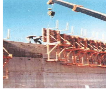
Resim 1. 44: Vinçle tırmanır kalıp uygulaması
