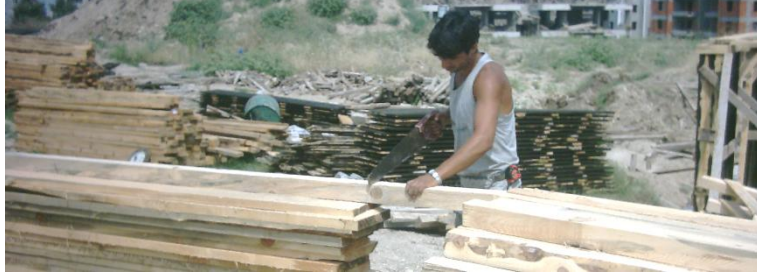
Resim 1.53: Dikme ve başlığı işaretlenen yerden kesilmesi
