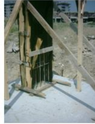
Resim 1.48: Kolon kalıbının montajı
