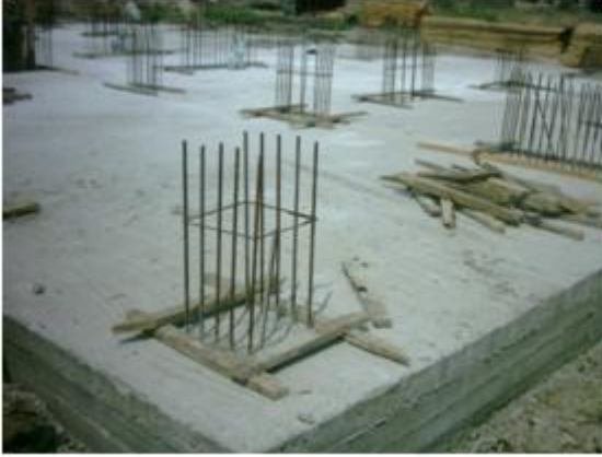
Resim 1.47: Kolon ızgaralarının çakılması
