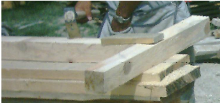
Resim 1.56: Başlık ile dikmeyi kulak tahtası ile birleştirmek
