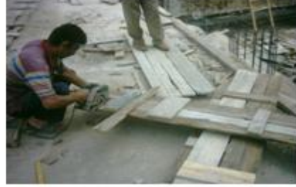
Resim 1.50: Kanatların hazırlanışı
