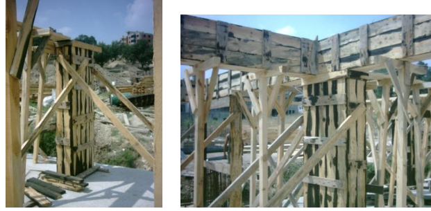
Resim 1.36: Ahşap kalıp uygulamaları
