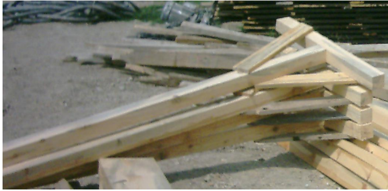
Resim 1.58: Hazırlanan dikmelerin istiflenmesi
