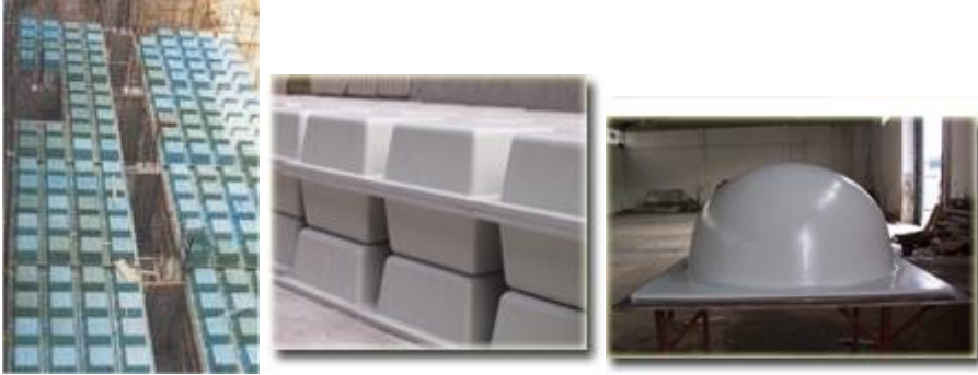
Resim 1.38: Kaset döşemelerde fiber kalıp uygulaması
