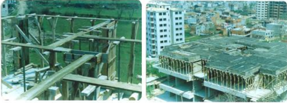
Resim 1.39: Klasik ahşap kalıp uygulamaları
