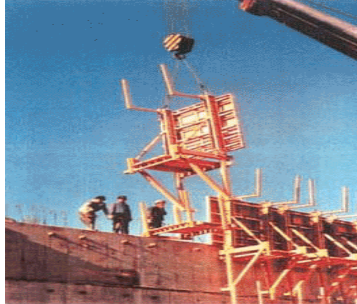
Resim 1. 44: Vinçle tırmanır kalıp uygulaması
