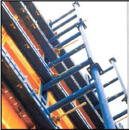
Resim 1.40: Plywood panel kalıp uygulamaları
