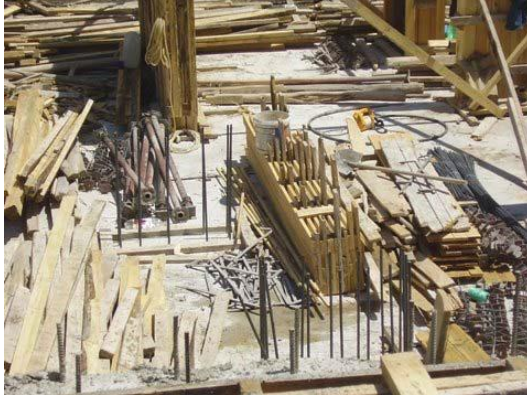
Resim 2.7: Sökülen malzemenin istiflenmesi
