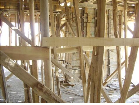
Resim 1.13: Kenarlara bağlı çapraz takviyeler Resim 1.14: Kenarlara bağlı çapraz takviyeler
