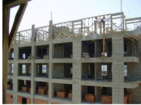
Resim 3.12: Kalıpların diğer katlarda da kullanılması
