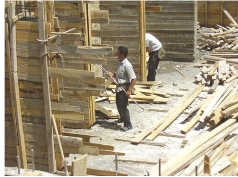
Resim 1.15: Malzemelerin sınıfına göre istif edilmesi Resim 1.16: Malzemelerin sınıfına göre istif edilmesi
