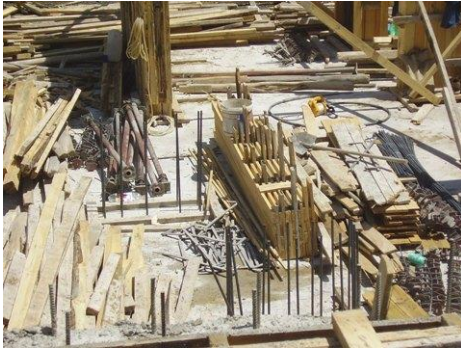
Resim 1.15: Malzemelerin sınıfına göre istif edilmesi Resim 1.16: Malzemelerin sınıfına göre istif edilmesi
