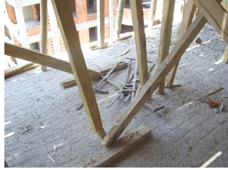
Resim 2.12: Dikmelerin sökülmesi
