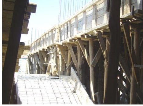
Resim 4.6: Kalıp malzemelerinin diğer katlarda da kullanımı
