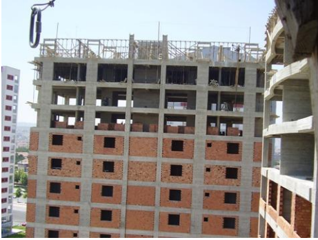
Resim 3.11: Kalıpların diğer katlarda da kullanılması
