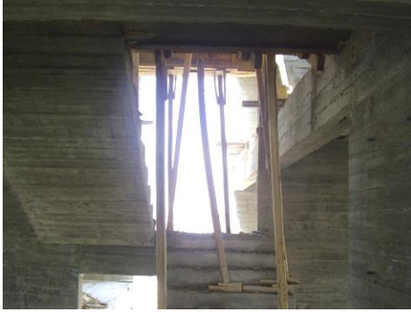
Resim 4.1: Merdiven kalıbı
