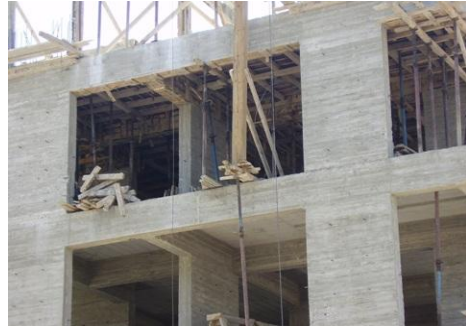
Resim 2.16: Yedek dikmelerin bırakılması
