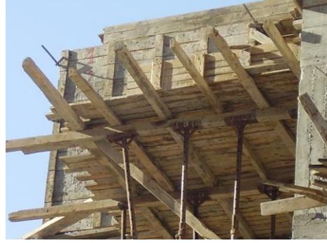
Resim 3.10: Balkon kalıpları
