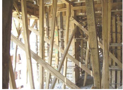
Resim 2.6: Çapraz takviyelerin sökülmesi
