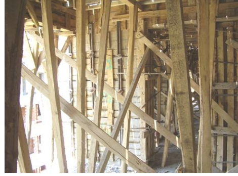
Resim 1.13: Kenarlara bağlı çapraz takviyeler Resim 1.14: Kenarlara bağlı çapraz takviyeler
