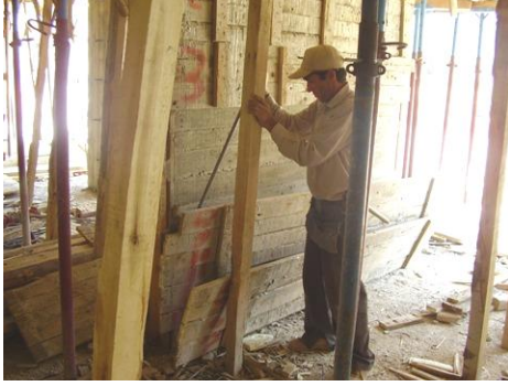
Resim 1.21: Kanatların sökülmesi
