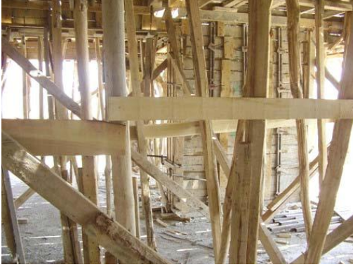
Resim 2.5: Çapraz takviyelerin sökülmesi
