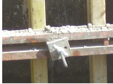
Resim 1.18: Bulonların sökülmesi
