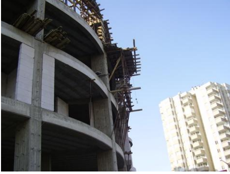
Resim 3.9: Balkon kalıpları
