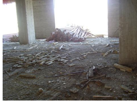
Resim 2.18: Dikmelerin istif edilmesi
