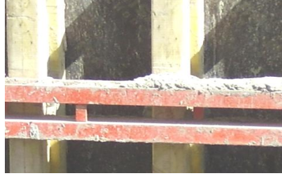
Resim 1.20: Destek profillerinin alınması
