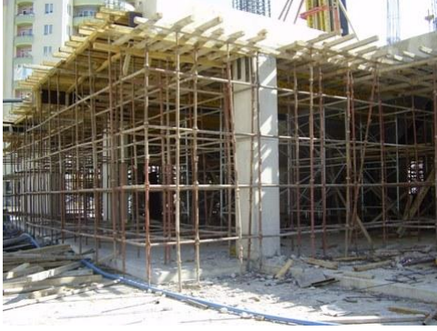
Resim 3.23: Çapraz ve takviyeler
