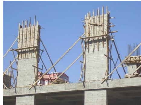
Resim 2.10: Dış yüzeylerin sökülümü
