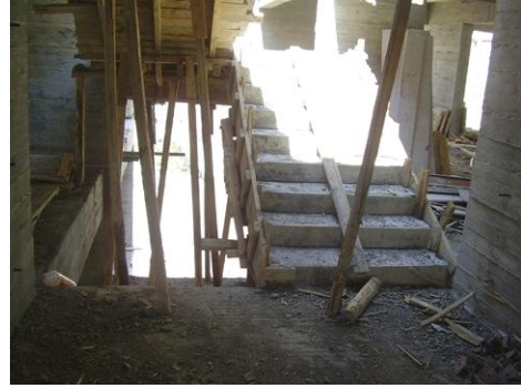
Resim 4.2: Merdiven kalıbı
