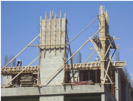
Resim 2.9: Dış yüzeylerin sökülümü
