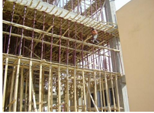
Resim 3.24: Çapraz ve takviyeler
