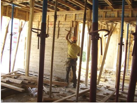
Resim 2.11: Dikmelerin sökülmesi
