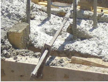
Resim 1.17: Kenarlardaki işkencelerin sökülmesi
