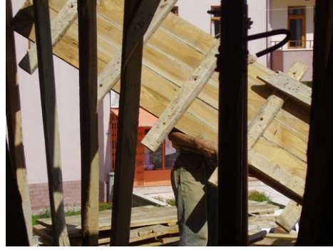
Resim 1.22: Kanatların sökülmesi
