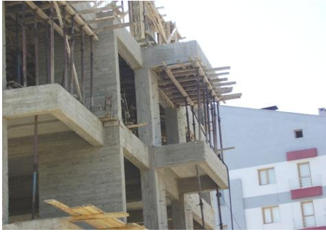
Resim 2.15: Yedek dikmelerin bırakılması
