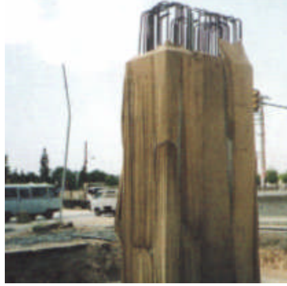
Resim 3.2: Islak branda ile korunmuş kolon betonu
