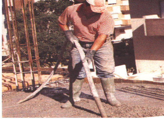
Resim 1.15: Vibratörün karışım merkezine tutulması
