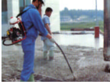
Resim 1.4b: Vibratörün uygulaması
