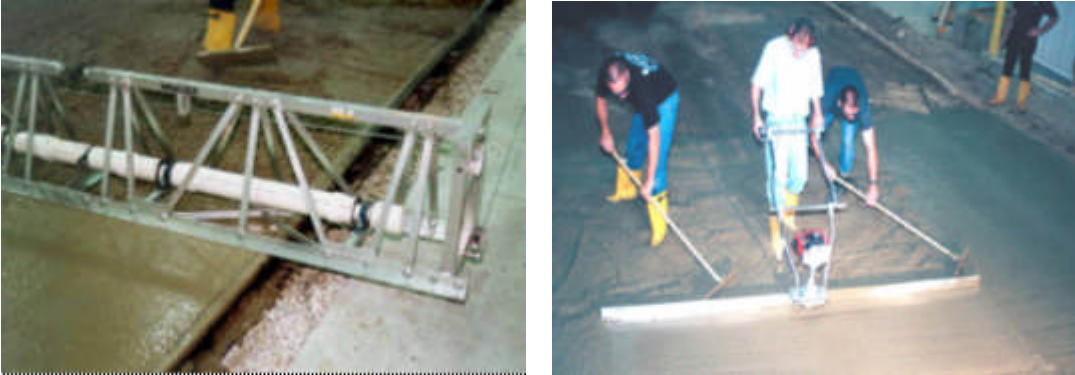
Resim 1.7: Yüzey (master) vibratörü uygulama örnekleri
