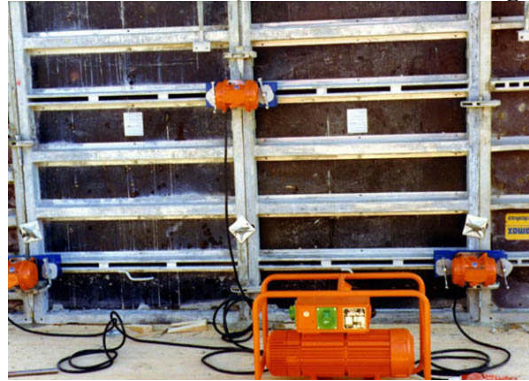
Resim 1.12: Elektrikli kalıp vibratörü uygulaması
