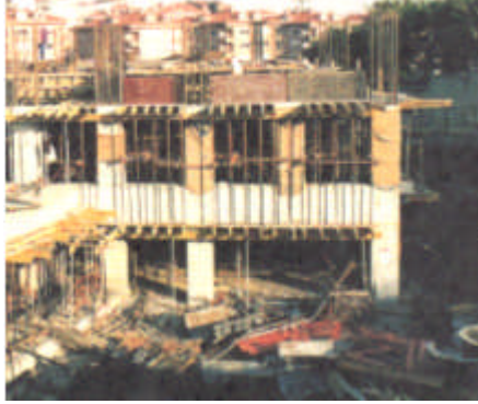
Resim 3.4: Islak çuvallarla korunmuş perde kolonlar
