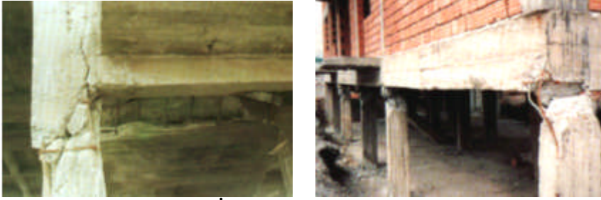
Resim 1.4-a: İyi sıkıştırılmamış beton örnekleri
