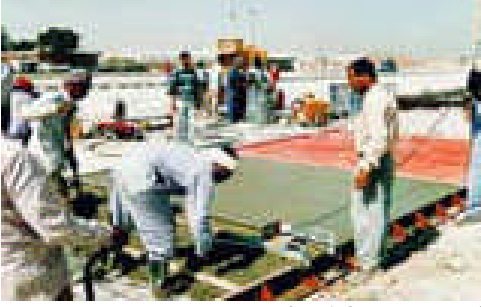
Resim 1.27: Yüzey vibratör uygulamaları
