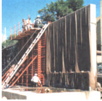
Resim 3.3: Islak branda ile korunmuş perde duvar betonu
