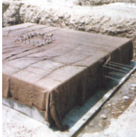
Resim 3.1: Islak branda ile korunmuş temel betonu
