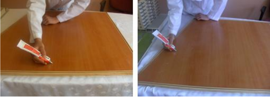
Resim 3.7: Altlık tahtasına yapıştırıcı sürme
