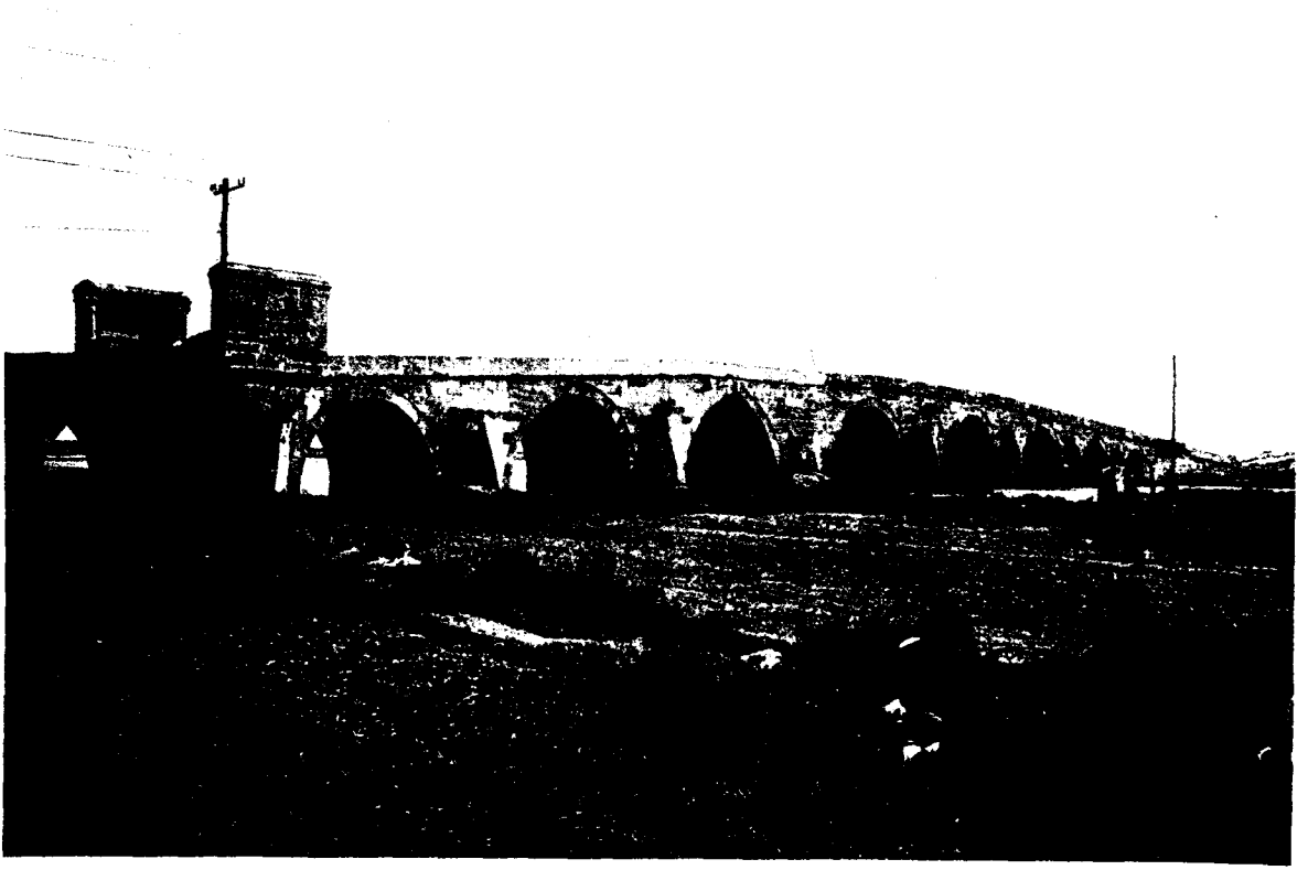
6. Büyükçekmece Köprüsü, 4. köprü (K. Çeçen'den)
