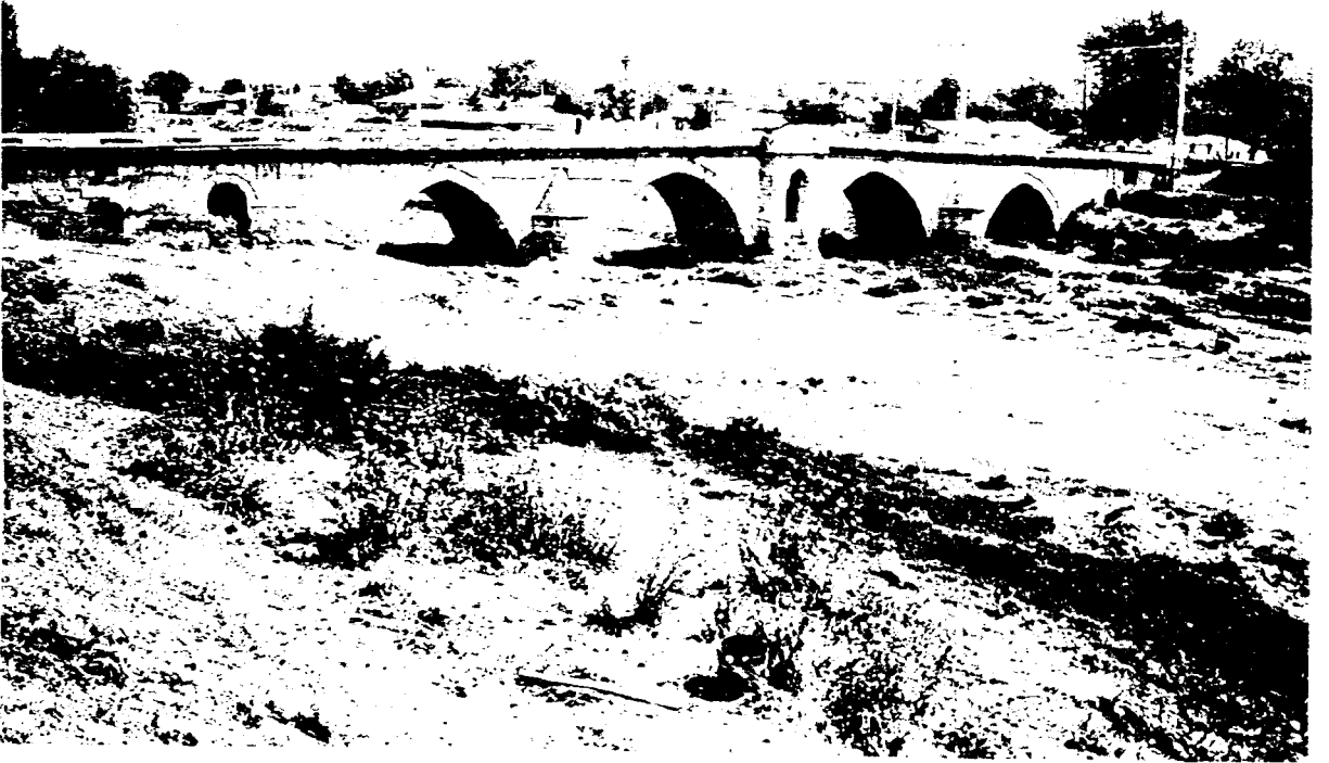
9. Lüleburgaz, Mehmed Paşa Köprüsü (K. Çeçen'den)
