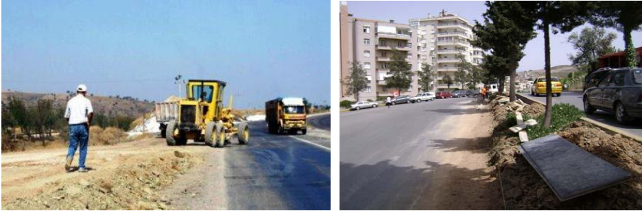
Resim 5.1: Yol yapım çalışmaları
