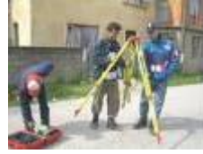
Resim 1.3: Parsel sınırlarının ölçülmesi
