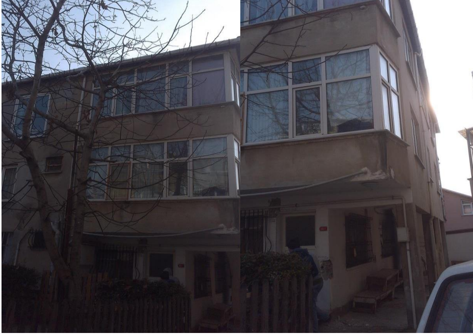
Resim 3.1. Bina ön cephe
