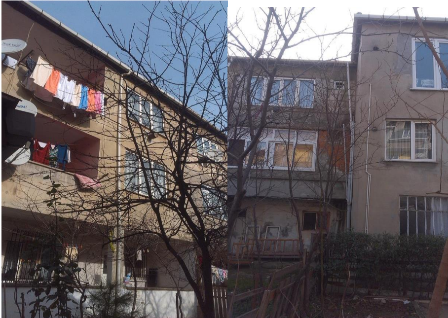
Resim 3.3. Bina sağ yan cephe
