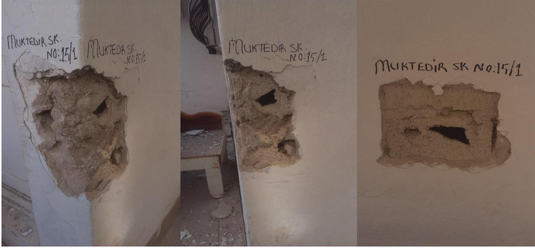
Resim 5.1. ,5.2. , 5.3. Yapıda Kullanılan Tuğla Tipleri
