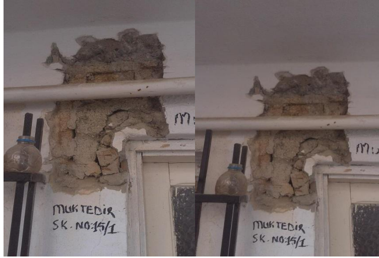
Resim 5.4. ,5.5. Yapıdaki Yatay Hatıllar
