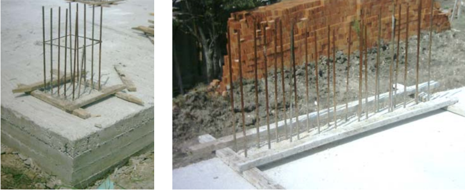
Resim 16: Kolon aplikasyonu ile kolonların yerlerinin belirlenmesi ve kuşakların çakılması
