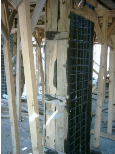
Resim 201: Kolonun takviye edilmesi ve yerleştirilmesi
