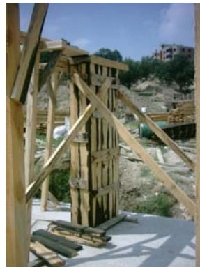
Resim 18: Kolonların ve perdelerin desteklenmesi
