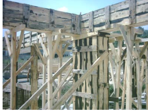
Resim 13: Çelik panel ve ahşap kolon kalıbı
