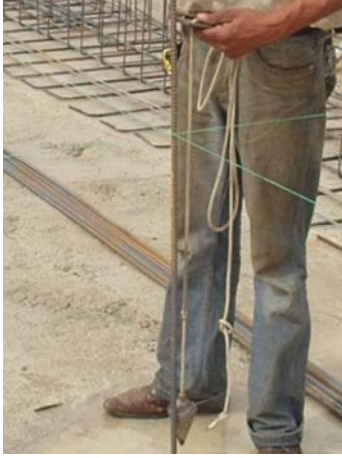
Resim 4: Köşe noktalarının tespiti ve temel donatısının hazırlanıp yerinde montajı
