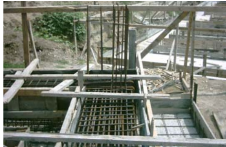
Resim 2: Sürekli temel kalıbı
