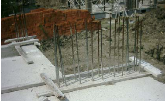
Resim 19: Izgaraların (kuşakların) tespiti
