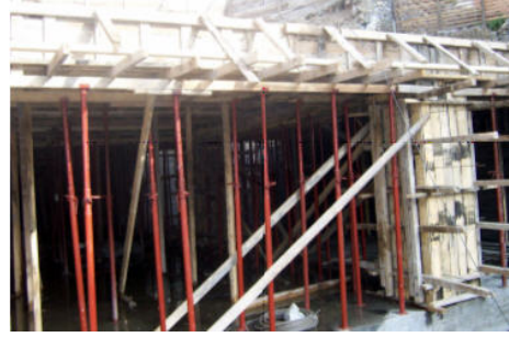
Resim 312: İç kanatların çakılması ve dış kanatta destek çitaları
