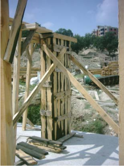
Resim 28: Destek ve kuşaklama
