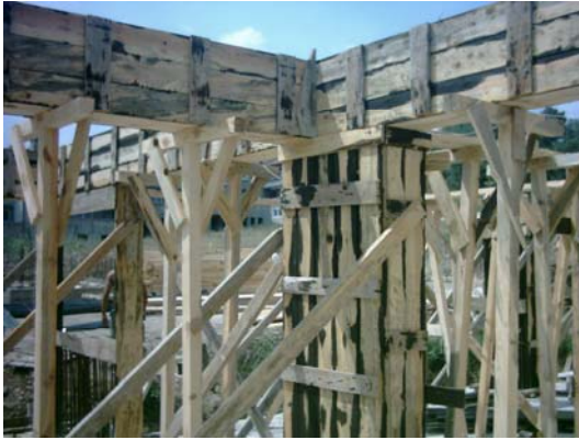
Resim 301: Kanatların çakılması ve dikmelerin kuşaklarla desteklenmesi
