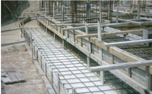
Resim 2: Sürekli temel kalıbı
