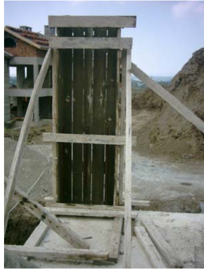
Resim 201: Kolonun takviye edilmesi ve yerleştirilmesi
