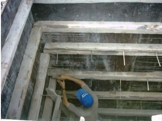
Resim 22: Bağlantı çubukları ve kilitlerin yerleştirilmesi ve kanatların gerdirilmesi
