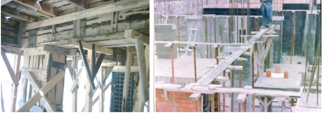
Şekil 44: Kolon, kiriş ve döşeme kalıbı ile kiriş taban tahtalarının çakılması
