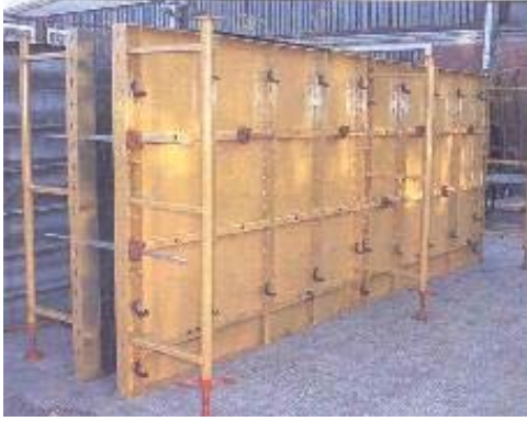
Resim 13: Çelik panel ve ahşap kolon kalıbı
