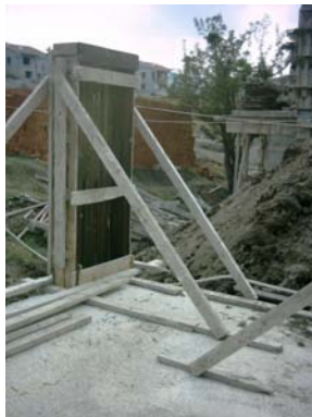
Resim 18: Kolonların ve perdelerin desteklenmesi
