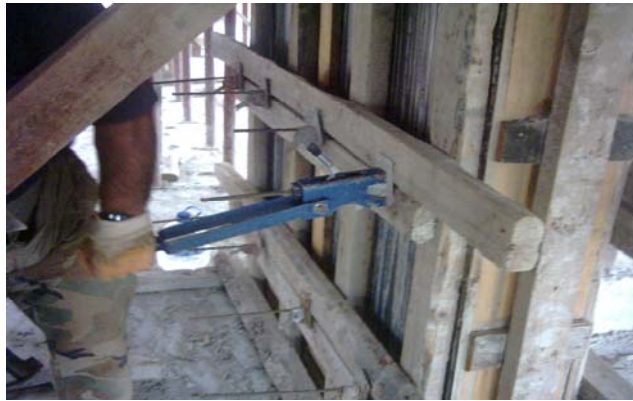
Resim 15: Kolonlarda metal kuşak uygulaması ve kanatların gerilmesi
