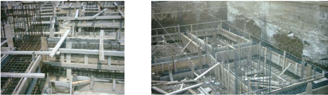
Resim 12: Kanatların desteklenmesi ve temel kalıbının uygulanması
