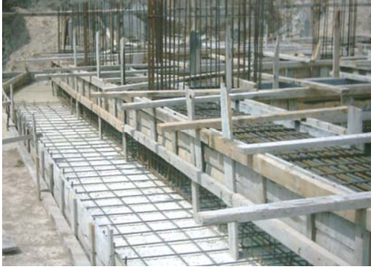
Resim 6: Ampatman alın kalıbı ve sürekli kiriş kalıbı ve kanatların gerdirilmesi
