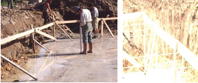
Resim 3: Aks bilgilerinin ip iskelesi kullanılarak zemine aktarılışı
