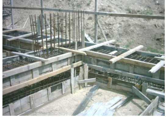
Resim 6: Ampatman alın kalıbı ve sürekli kiriş kalıbı ve kanatların gerdirilmesi
