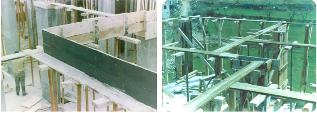
Resim 27:Kolon, kiriş ve döşeme kalıbı
