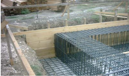
Resim 5: Kanatların hazırlanması ve desteklenmesi
