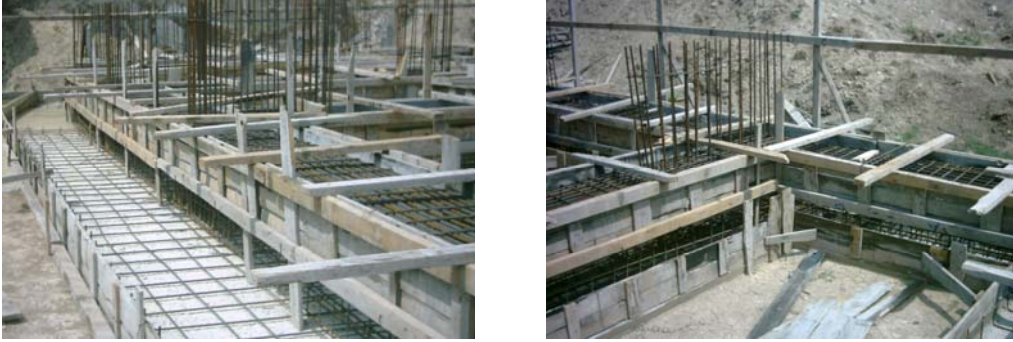
Resim 11: Ampatmanın alın kalıbı ve kanatların gerilmesi
