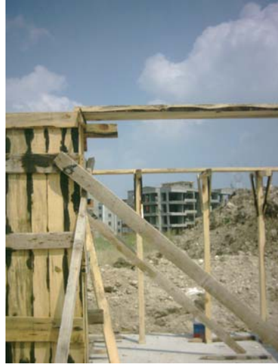
Resim 29: Taban tahtası ve dikme yerleştirme
