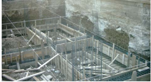
Resim 7: Kanatların desteklenmesi ve temel kalıbı uygulaması
