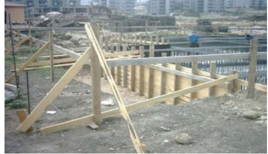
Resim 5: Kanatların hazırlanması ve desteklenmesi
