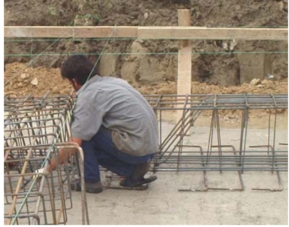
Resim 4: Köşe noktalarının tespiti ve temel donatısının hazırlanıp yerinde montajı
