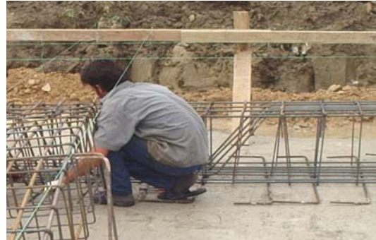
Resim 9: Köşe noktalarının tespiti ve temel donatısının hazırlanıp yerinde montajı
