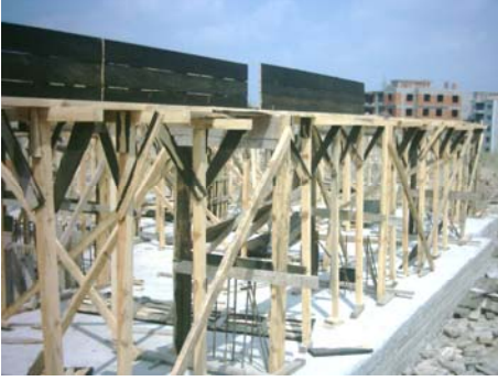
Resim 24: Dikmelere çaprazların çakılması
