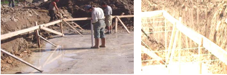
Resim 8:Aks bilgilerinin zemine aktarılışı ve ip iskelesinin yapılması
