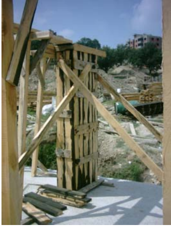
Resim 21: Kanatların takviye edilmesi ve kolon kuşaklarının çakılması
