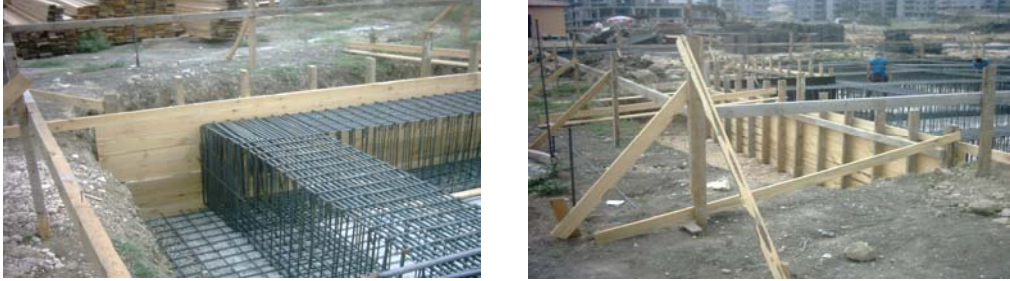
Resim 10: Kanatların hazırlanışı ve desteklenmesi
