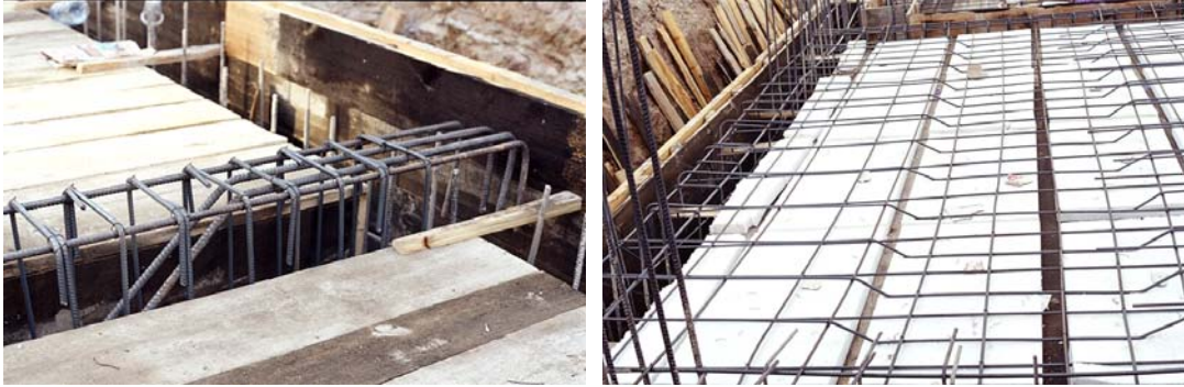
Resim 356: Kaplamanın çakılarak kiriş ve döşeme donatılarının yerleştirilmesi
