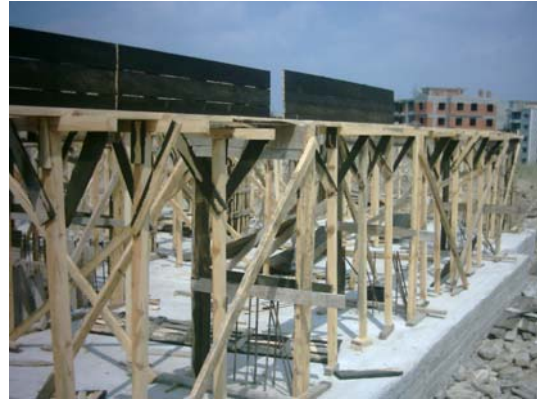
Resim 301: Kanatların çakılması ve dikmelerin kuşaklarla desteklenmesi
