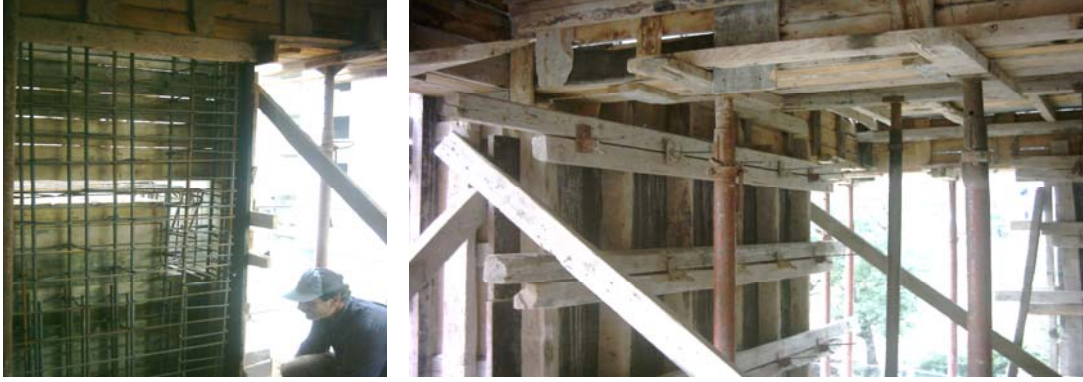
Resim 345: Perde donatısının yerleştirilmesi ve kuşakların çakılması
