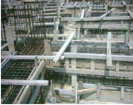
Resim 7: Kanatların desteklenmesi ve temel kalıbı uygulaması
