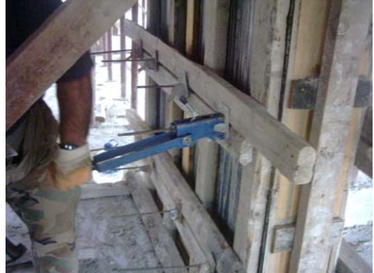
Resim 22: Bağlantı çubukları ve kilitlerin yerleştirilmesi ve kanatların gerdirilmesi
