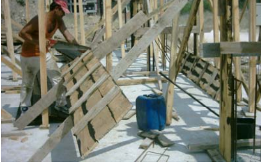
Resim 20: Kanat hazırlama
