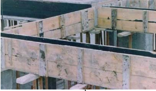
Resim 312: İç kanatların çakılması ve dış kanatta destek çitaları
