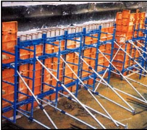
Resim 17: Perdelerin çubuklarla desteklenmesi
