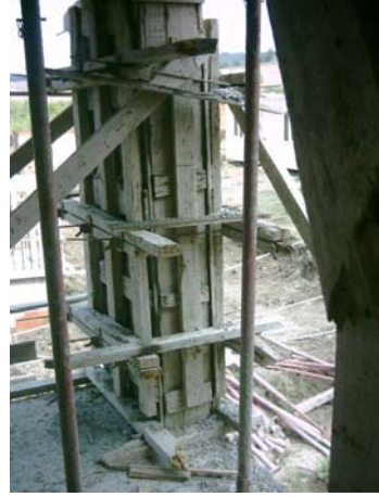
Resim 21: Kanatların takviye edilmesi ve kolon kuşaklarının çakılması
