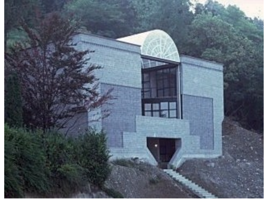
Casa a Viganello
